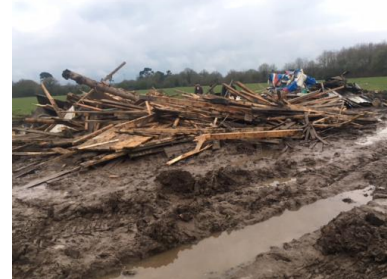
La tour du collectif Lamassacré, après démolition par les gendarmes, le 9 avril 2018 (JL)
