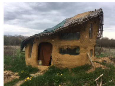
La cabane à l'entrée du puits d'Alex, à l'est de la ZAD, détruite par les gendarmes. (JL)
