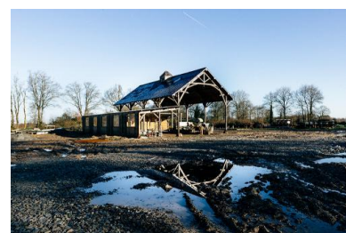
Le « hangar de l'avenir » dont la construction a débuté pendant la manifestation des bâtons en octobre 2016 © Yann Levy / Hans Lucas
